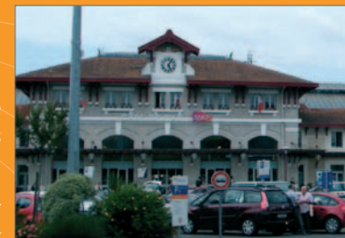
Future gare LGV, la gare de Dax a achevé fin 2010 la première étape de son réaménagement avec la mise en accessibilité totale de ses quais. La prochaine sera la création d'un pôle d'échange multimodal.
