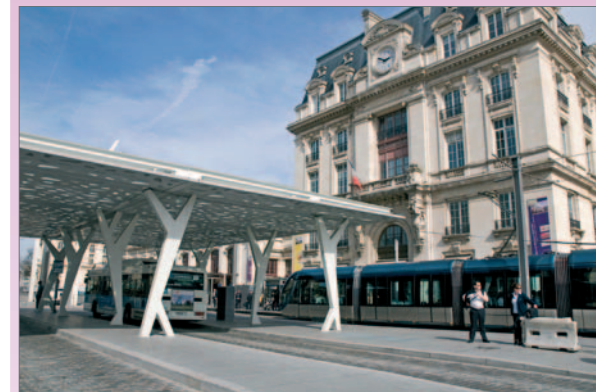
Sur le parvis de la gare Saint-Jean, la halle multimodale assure un passage rapide et sécurisé du bus au tram et au train.
